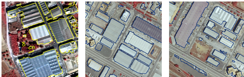
Figura 23. Ejemplos de la detección de edificaciones de tipología industrial en Moncada (izquierda) y Sagunto (centro y derecha).
